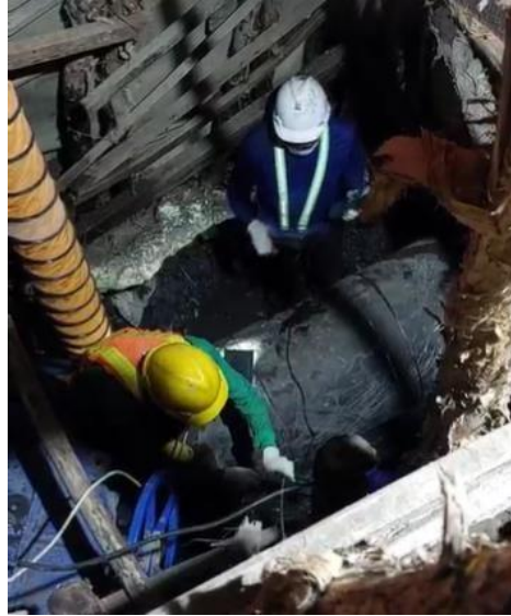
Gambar 1.7 Relokasi pipa yang dilakukan untuk distribusi air bersih
