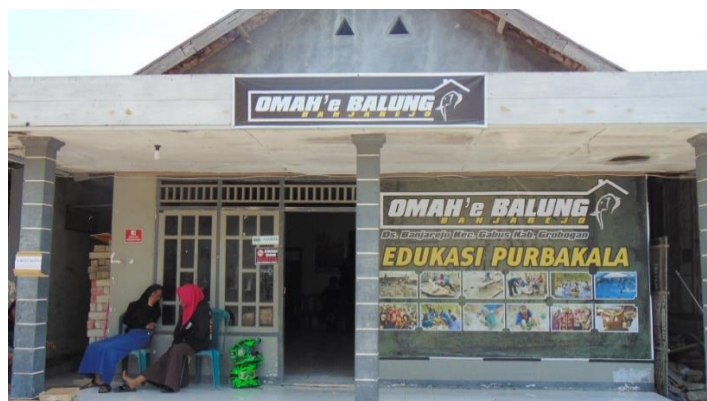
Omah Balung Tampak Depan
