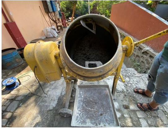
Gambar 4.18 Pengadukan Material dengan Mixer
