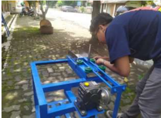
Gambar 3. 28 Pemasangan part mesin
