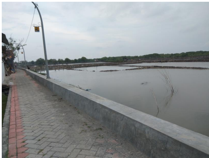
Kondisi Talud di RW 05
