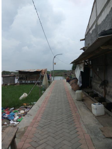
Kondisi Jalan di RW 05
