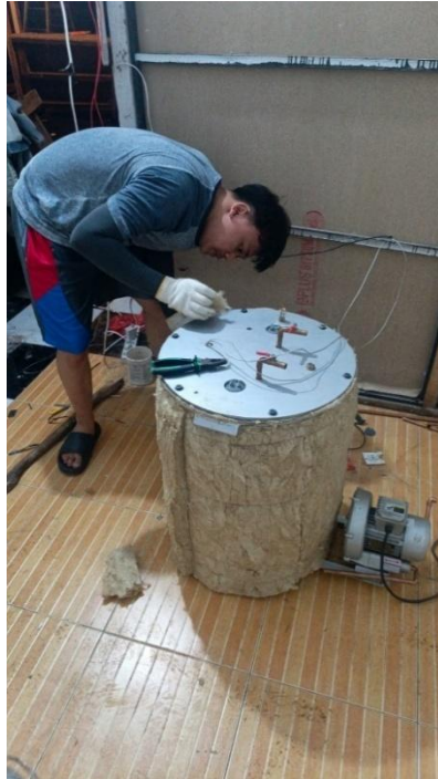
Gambar 4. 4 Proses Pemasangan Rockwool dan Aluminium Foil
