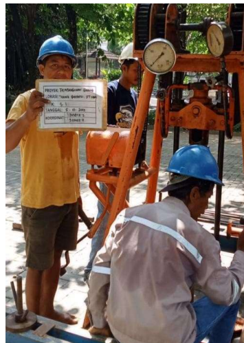
Gambar 4.23 Dokumentasi Uji Sondir
