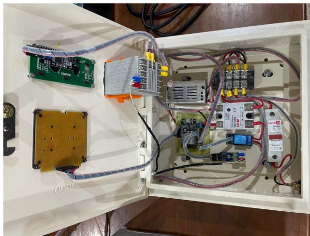
Gambar 4- 5 Hasil Akhir Perakitan Komponen pada Box Panel
