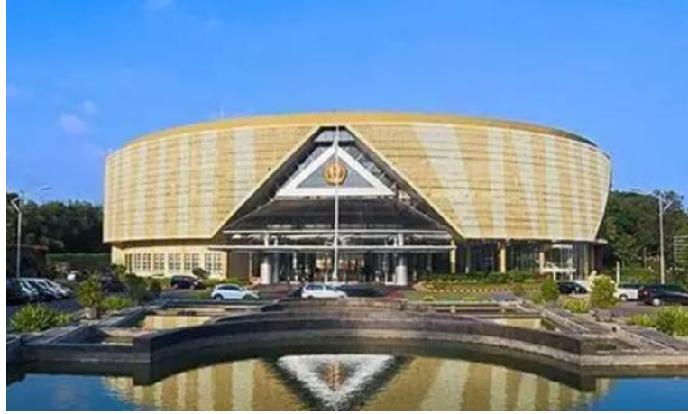
Gambar 2. 3 Gedung Rektorat Universitas Padjadjaran
