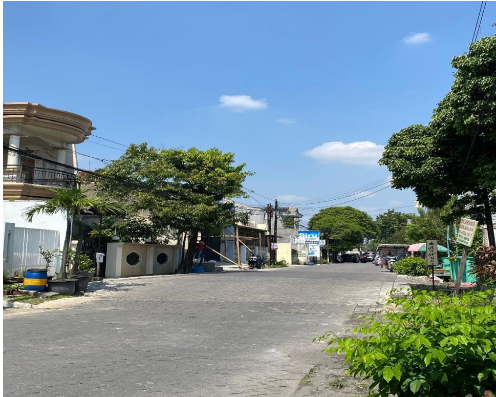
Gambar 2. 4 Kondisi Penaikan Muka Jalan
