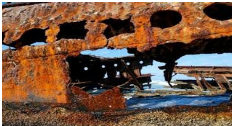
Gambar 2. 2 Korosi pada plat baja
