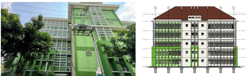
Gambar 3. 11 Tampak Barat Laut Gedung Gizi Sumber : dokumentasi pribadi, 2026
