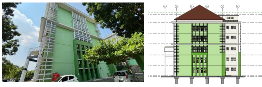
Gambar 3. 10 Tampak Timur Laut Gedung Gizi Sumber : dokumentasi pribadi, 2026
