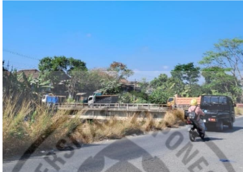
Gambar 2.4 Jembatan Batarsari sebagai Penghubung Jl. Bengkung Raya
