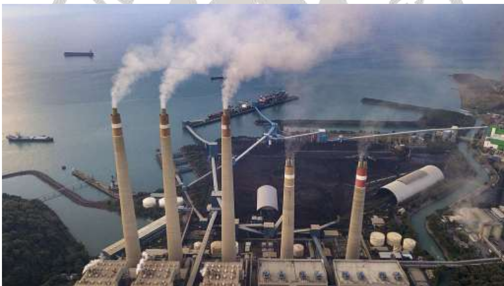
Gambar 2. 1 Unit PLTU XXX (Sumber : PLN Indonesia Power)
