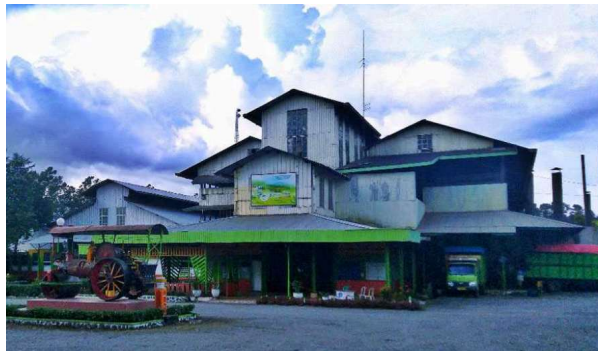
Gambar 2.6. Eksterior Pabrik Kayu Teh Aro (Sumber: Website Resmi Kayu Teh Aro)
