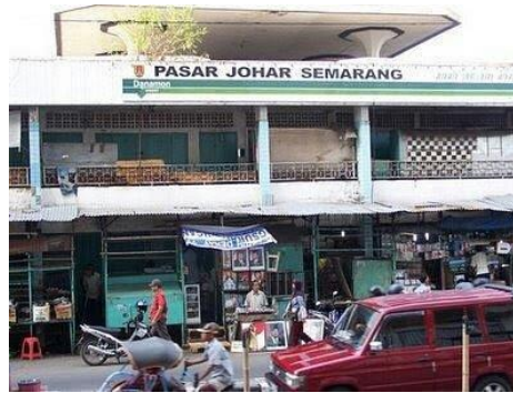
Gambar 2. 2 Pasar Johar sebelum kebakaran.
