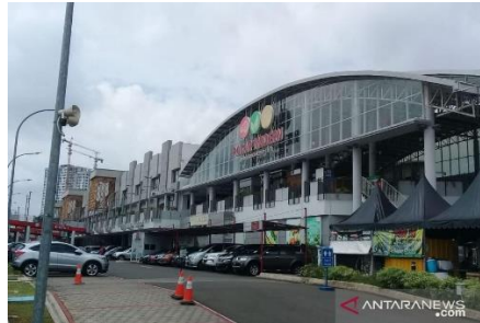
Gambar 2. 9 Fasad Pasar Modern BSD.
