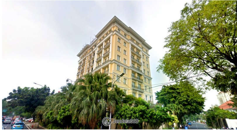
Gambar 2.11 Apartemen Cik Ditiro Jakarta Sumber: jendela360.com
