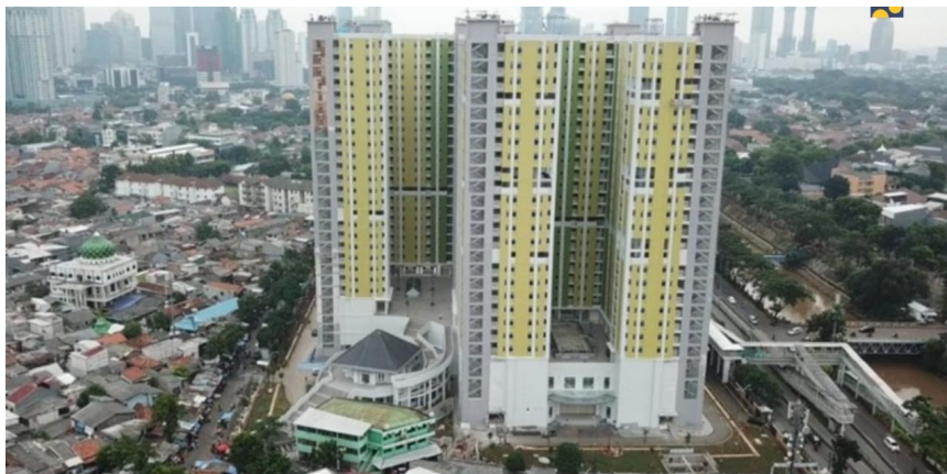
Gambar 2.9 Rusunawa Pasar Rumput Jakarta
