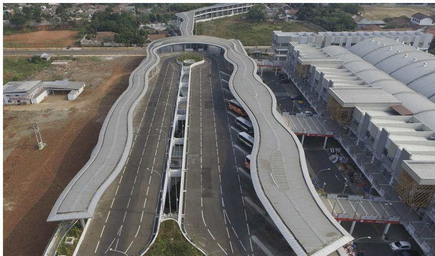
Gambar 1.2 Terminal Stasiun Cisauk Intermoda Sumber: colorbond.id
