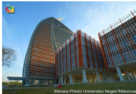
Gambar 3. Penggunaan Louvre Vertikal Pada Menara Phinisi Universitas Negeri Makassar
