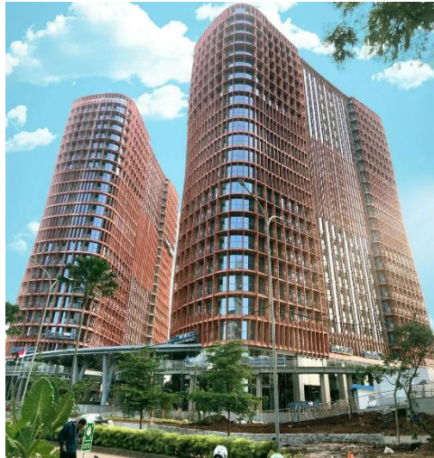
Gambar 4. Penggunaan Louvre Vertikal Pada Bangunan South Quarter, Jakarta Selatan Sumber: rooma21
