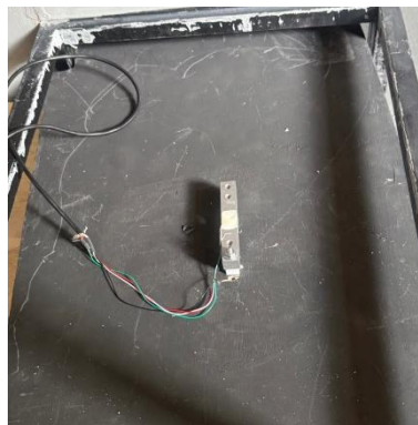
Gambar 3. 12. Penempatan load cell bagian bawah mixing tank
