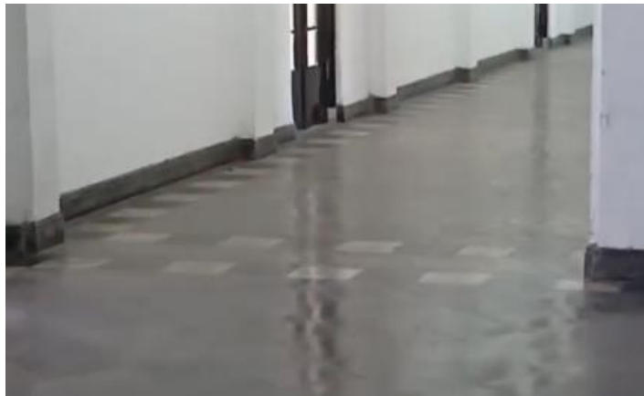
Gambar 22. Lantai Ubin Gedung Sumber: Sarkub Indonesia
