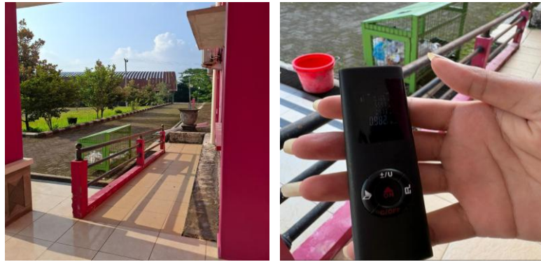
Gambar 4. 3 Kondisi Eksisting ramp Rusunawa UNDIP Gedung E
