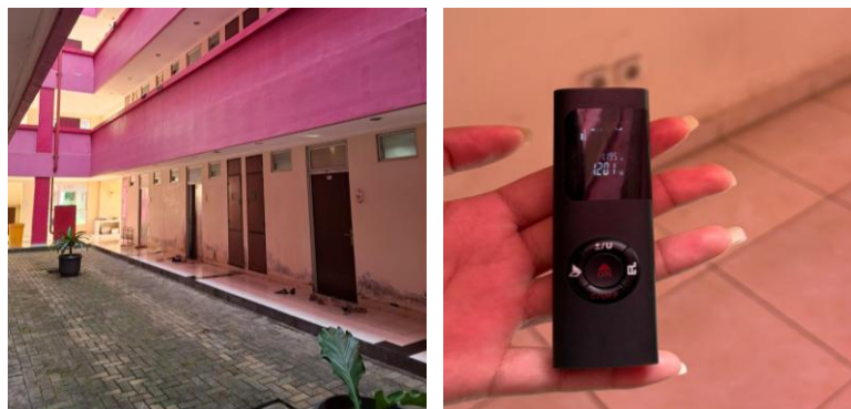
Gambar 4. 1 Kondisi Eksisting Koridor Rusunawa UNDIP Gedung E
