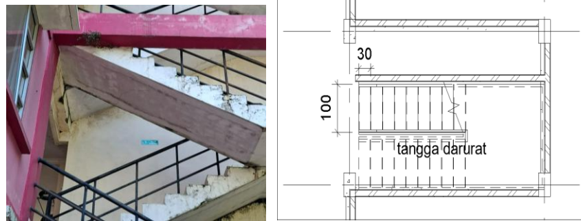
Gambar 4. 41 Kondisi Eksisting Sarana Evakuasi Rusunawa Undip Gedung E
