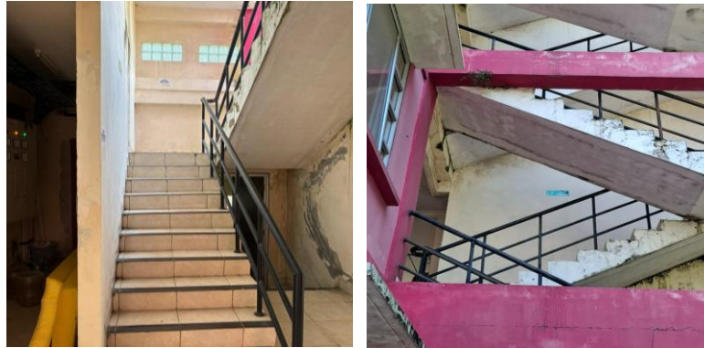
Gambar 4. 10 Kondisi Eksisting Sarana Evakuasi Rusunawa UNDIP Gedung E
