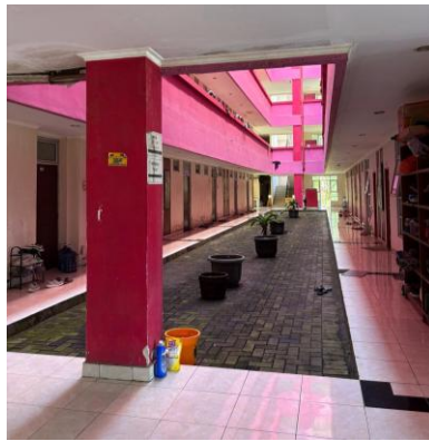
Gambar 4. 7 Kondisi Lantai Koridor Rusunawa UNDIP Gedung E Tidak Terdapat Guiding Block
