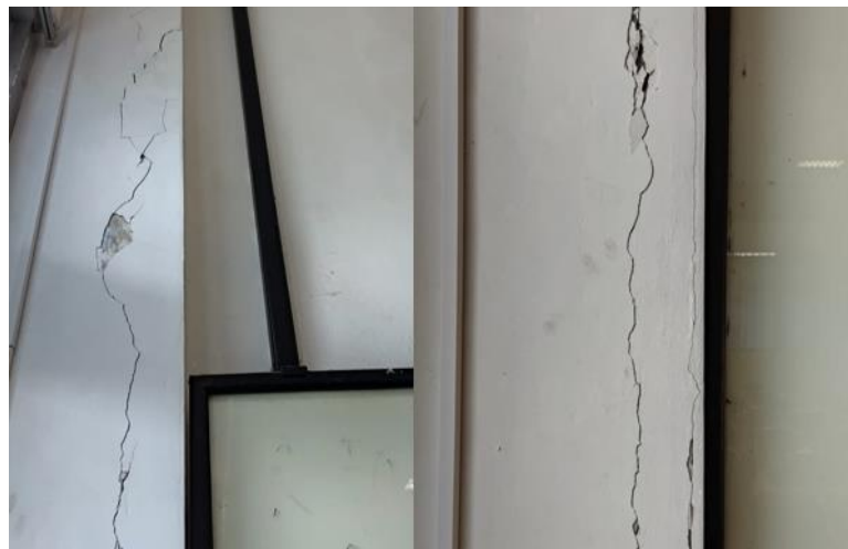
Gambar 1.3 Dinding Pada Ruang K303 Gedung Geothermal
