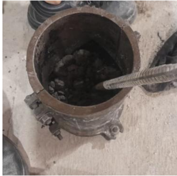
Gambar 3.70. Pemadatan Campuran Beton
