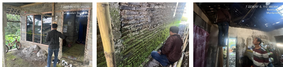
Gambar 23. Pengamatan Kondisi Rumah (Sumber: Penulis)
