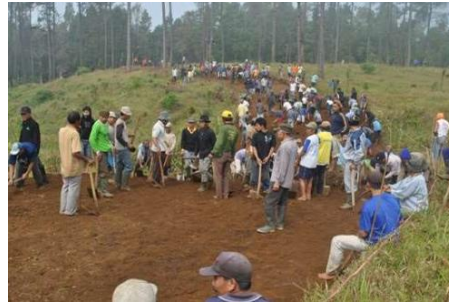
Gambar 2. 4 Gotong Royong Pembangunan Jalan Akses Kawasan D'Las
