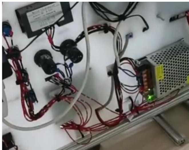
Gambar 4. 2 Pemasangan Kabel pada Alat
