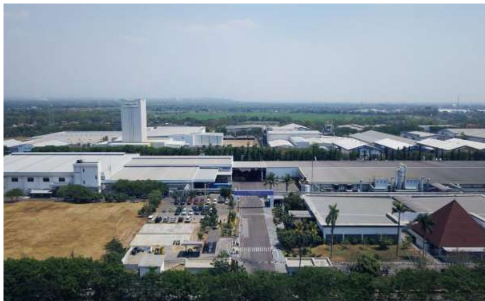
Gambar 1. 5. Lahan Industri dan Bangunan Pabrik Siap Pakai di PIER ( sier.co.id , 2021)
