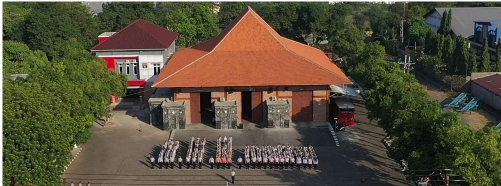
Gambar 2. 6 Gedung UPTD Trans Semarang
