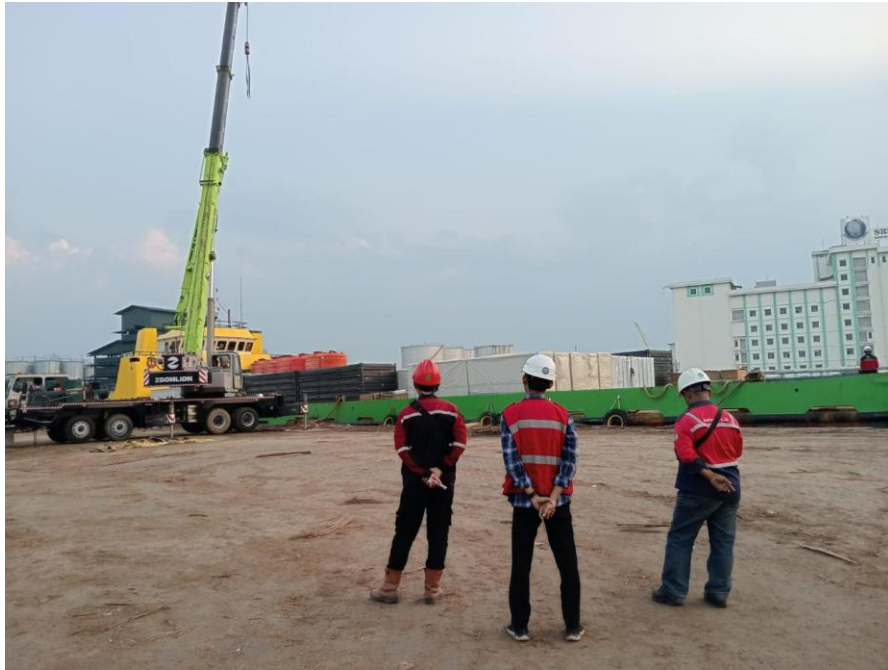
Gambar 4. 6 Pengecekan Area Kerja
