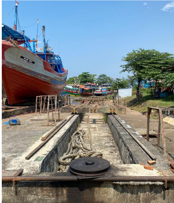
Gambar 2. 2 Dock Pada Galangan Kapal Kayu Di Batang (Sumber: Penulis, 2026)
