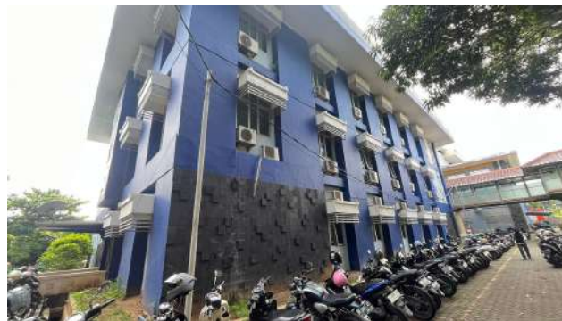
Gambar 4.4 Kondisi Aktual Tampak Belakang Fasad FPIK B UNDIP
