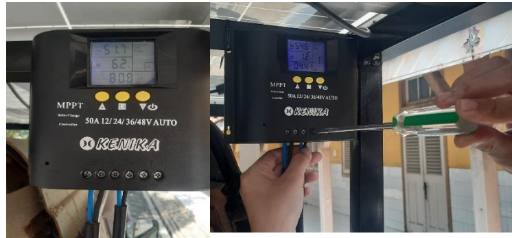
Gambar 3.9 Pemasangan solar charger controller
