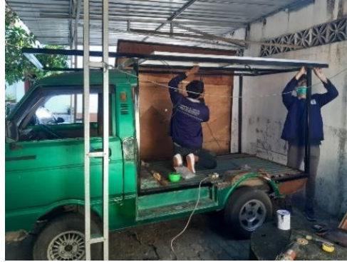
Gambar 3.6 Pemasangan panel surya ke atas rangka dudukan
