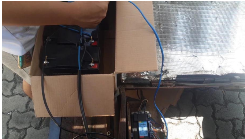
Gambar 3.12 Pemasangan akumulator ke controller motor
