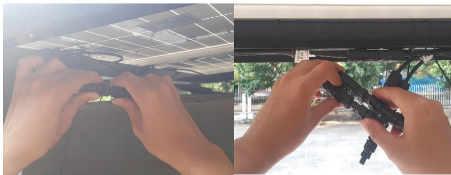
Gambar 3.7 Menseri paralelkan 6 unit panel surya
