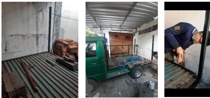
Gambar 3.5 Proses pembuatan rangka dudukan panel surya
