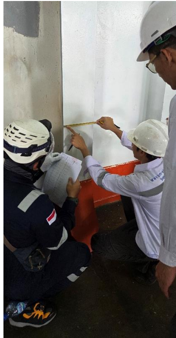
Gambar 4.8 Pengukuran Dimensi Aktual Web Frame Modified oleh Tim Teknis Galangan dan Surveyor BKI sebagai Bagian dari Final Inspection
