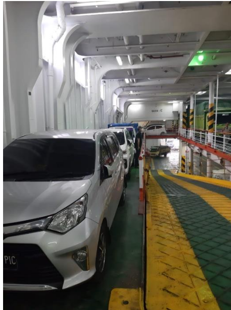
Gambar 4.13 Kondisi Upper Car Deck (Deck-C) Setelah Implementasi Redesain Web Frame pada Rentang Frame 74–116 Sisi Kiri
