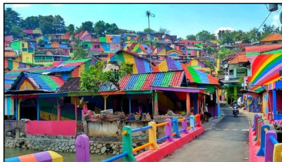
Gambar 2.6 Kondisi setelah di renovasi menjadi Kampung Pelangi
