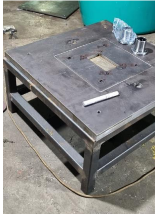
Gambar 3.20 Perakitan base plate pada rangka utama
