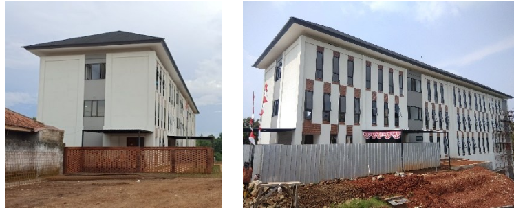
Gambar 4.1.2.1 1Eksisting Bangunan SMK TI BAZMA
