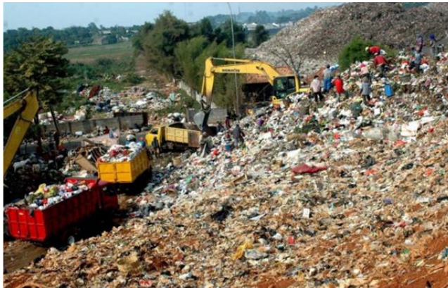
Gambar 2.2 Metode Penanganan Sampah dengan Open Dumping
