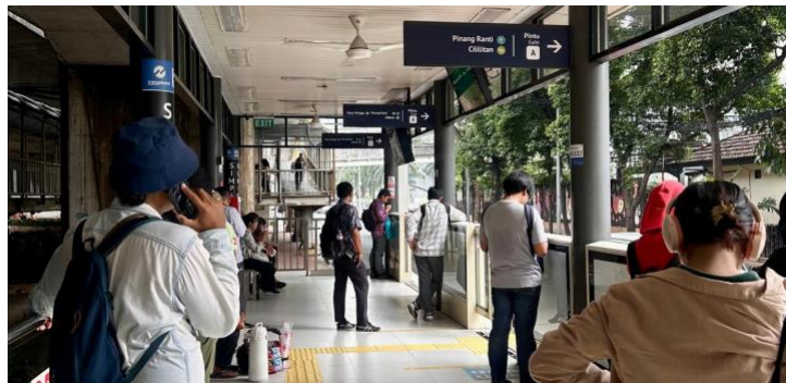
Gambar 2. 4 Kondisi halte Kuningan Barat
