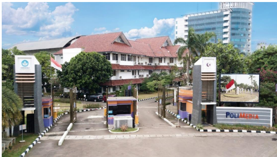
Gambar 4. 1 Gedung Polimedia Jakarta
