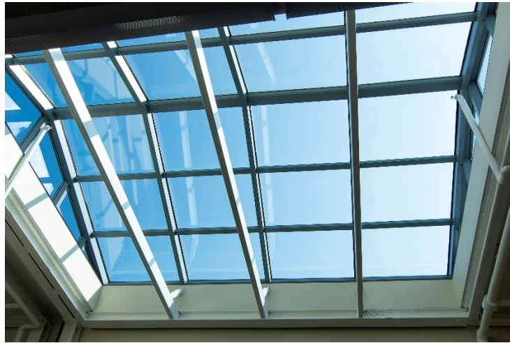
Gambar 8 Skylight pada atap
