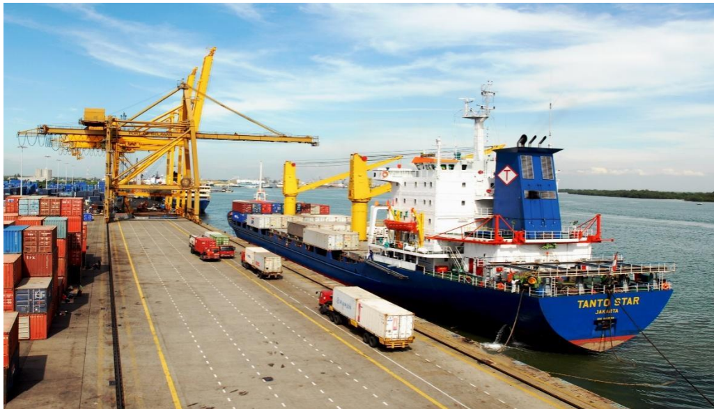
Gambar 1. 2 Pembongkaran Peti Kemas di Pelabuhan Tanjung Perak Surabaya (Sumber: Pelabuhan Tanjung Perak Surabaya)
