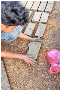
Gambar 3. 33 Mencetak dan Memadatkan Tanah Liat
