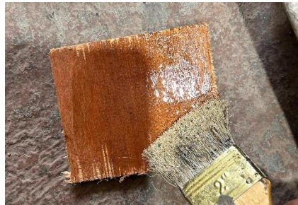
Gambar 3. 40 Mengolesi Plywood Dengan Minyak Bekisting
