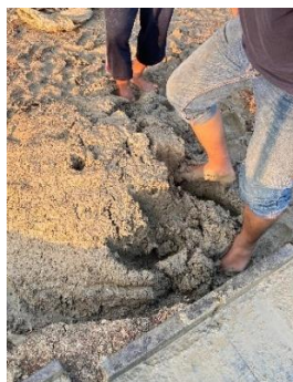
Gambar 3. 31 Memadatkan Tanah Liat
