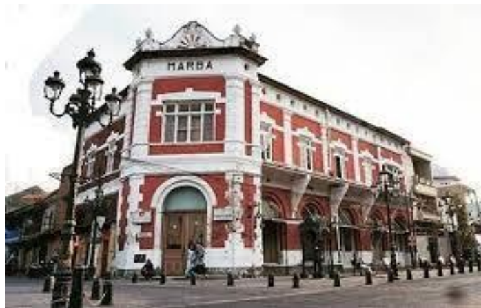
Gambar 6. Gedung Marba Masa Kini
