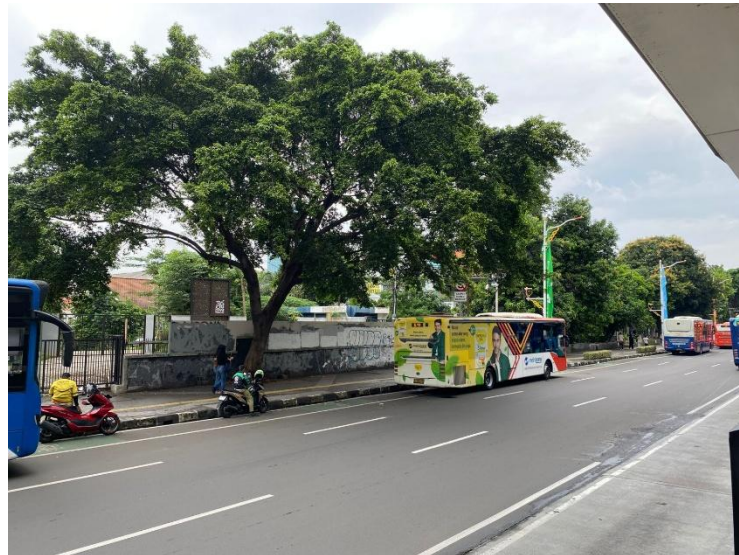
Gambar 4. 13 Kondisi Jalur Sepeda Tanpa Pembatas Fisik
