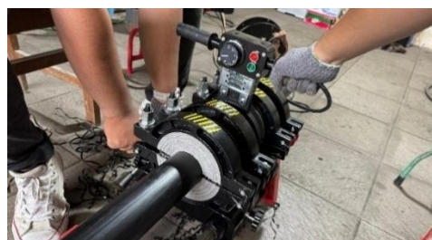
Gambar 4. 2 Pengelasan pipa HDPE untuk spesimen pengujian tarik
