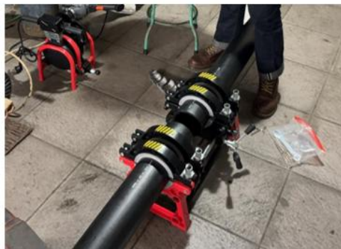
Gambar 4. 6 Proses pengelasan pipa HDPE untuk spesimen pengujian hidrostatik
