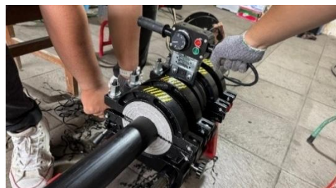
Gambar 4. 2 Pengelasan pipa HDPE untuk spesimen pengujian tarik
