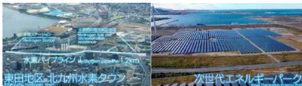
Gambar 3. 10. Pipa Hidrogen di Kitakyushu dan Taman Panel Surya
