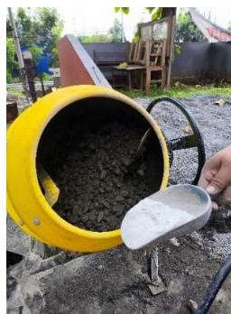
Gambar 3. 66 Pencampuran Bahan
